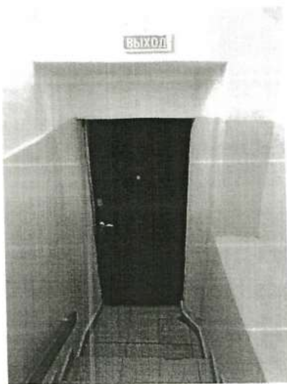
Запасной выход (внутри) № 1
